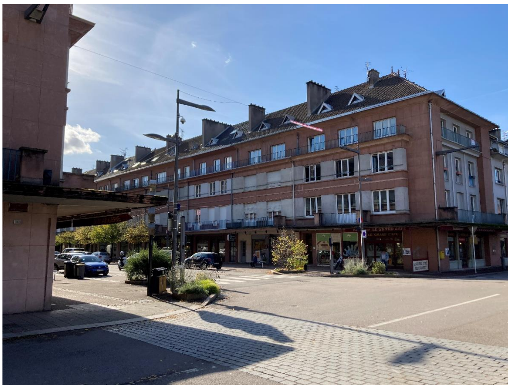
La rue Thiers de Saint-Dié-des-Vosges, témoin de la reconstruction après la Seconde Guerre mondiale
