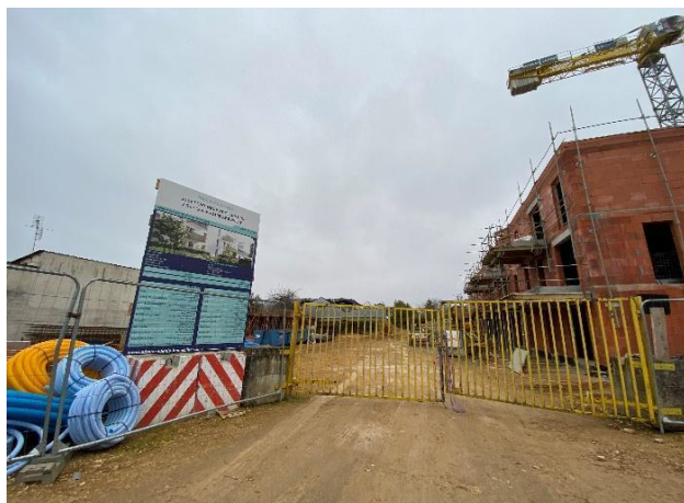
Opération en cours de Pont Neuf – Poitiers – BDX dans le quartier du Pont-Neuf, Poitiers – 61 logements collectifs et 7 logements individuels. Photographie prise en février 2022. Crédits : Université Paris-Dauphine.
