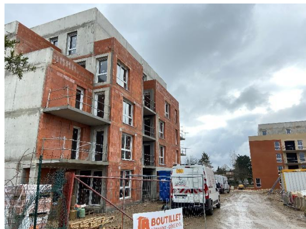
Opération en cours de Bouygues Immobilier dans le quartier de la Gibauderie, Poitiers – 61 logements et une résidence étudiante de 112 chambres. Photographie prise en février 2022. Crédits : Université Paris-Dauphine.
