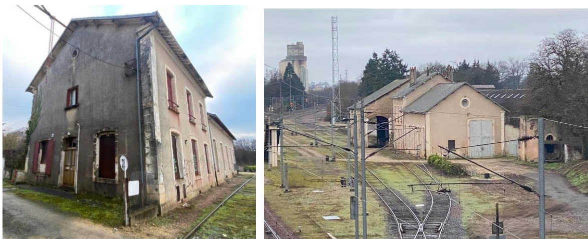
Friches ferroviaires situées de chaque côté du quai de la gare de Lusignan. Photographies prises en février 2022. Crédit : Université Paris-Dauphine.
